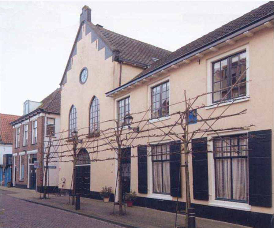
Recente foto van de voormalige kerk van de Chr. Gereformeerde Gemeente
