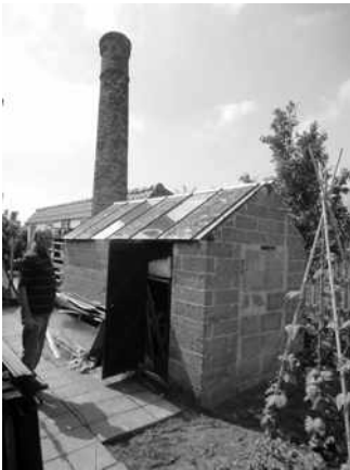
Ketelhuis met schoorsteen
