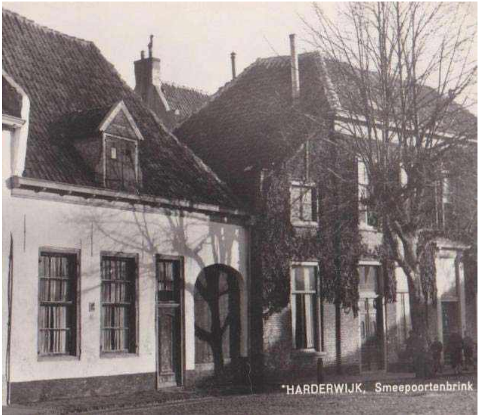
De Paradijspoort voor de restauratie
