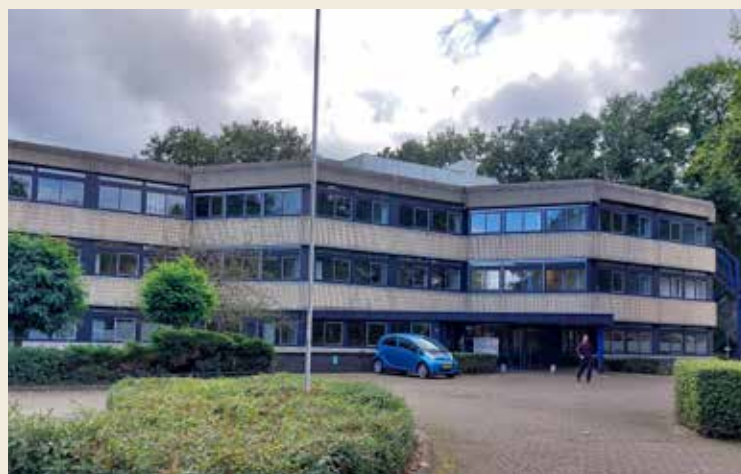
Structuralistisch kantoorgebouw aan Engelsef 35 (foto: Gelders Genootschap)
