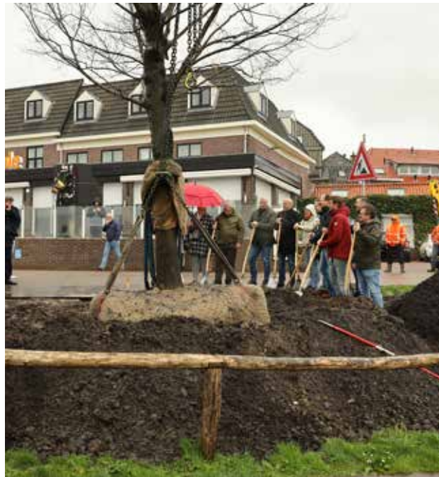
De werkzaamheden aan de Wijde Wellen begonnen in maart met het planten van deze boom
