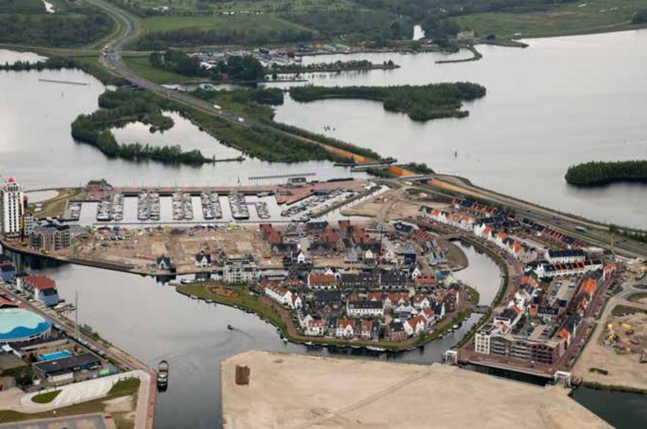
EINDPLAATJE - De realisering van het Waterfront vordert, zoals goed is te zien. Ook mooi in beeld de vernieuwde N302 en de nieuwe jachthaven De Knar. Alle elementen komen hier bij elkaar. Het is nog niet af, maar goed te zien is hoe het eindplaatje er straks gaat uitzien. (Foto: Bram van de Biezen)
