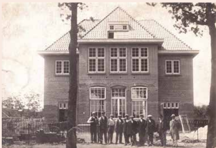
Hierdenaren tijdens de verbouwing van de school in 1929. Let op de bakstenen links op de foto. Rechts staat een kozijn tegen de muur geleund. De klus is nog niet geklaard.
